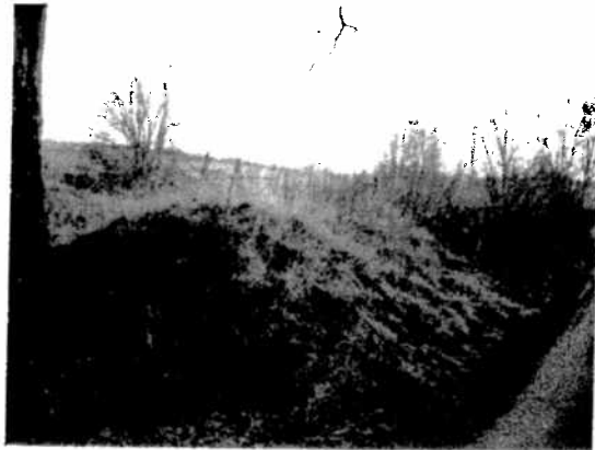
2. Widok wału ziemnego zabezpieczającego przed wjazdem na teren składowiska.
